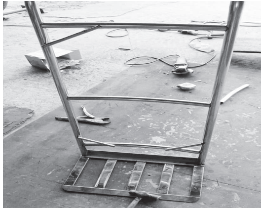
ภาพที่ 2 ทำการเชื่อมบริเวณฐานตะแกรงรองวัสดุ
